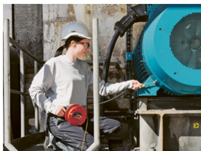
1 Verifica del conduttore di protezione
